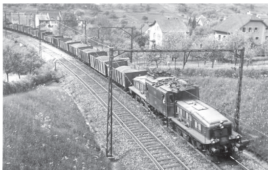
Ein Güterzug gezogen von einem «Krokodil» beim Viadukt in Gelterkinden.
