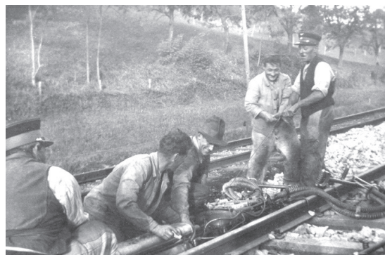
Geleisarbeiten auf der Strecke, um 1935.
